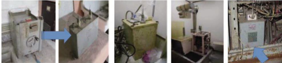
昇降機等の制御盤 (低圧進相コンデンサー)
