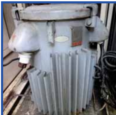
トランス（変圧器）
