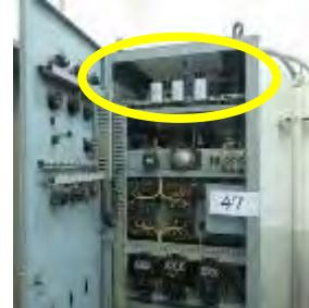
可変周波数電源装置の低圧コンデンサー
