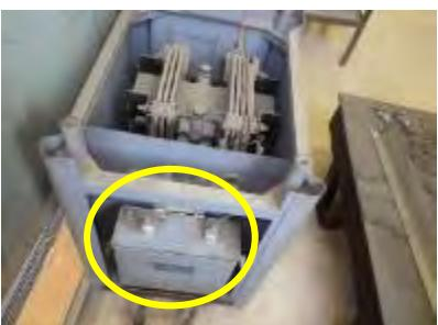
電気溶接機には低圧コンデンサーが側面又は内部に設置されている。側面に設置されていない場合は、蓋を開け内部に設置されているか確認する。
