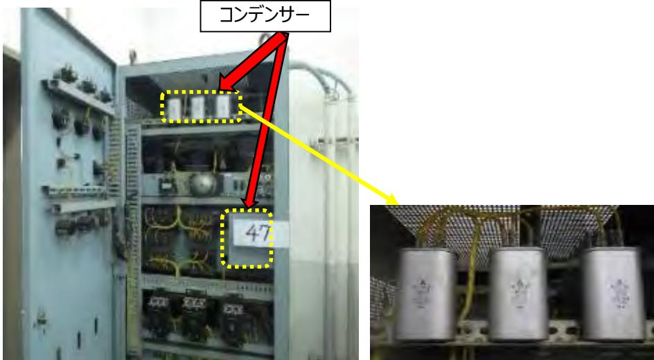
各種の理化学機器や制御装置には部品として小型のコンデンサーが組み込まれたものがある。電源回路や電子回路等の部品に使用されている電解コンデンサー、フィルムコンデンサー、セラミックコンデンサー等には絶縁油が使用されていないのでPCB汚染の可能性はない。小型のコンデンサーではメーカーが製造年等を識別する固有の記号を印字している場合がある。識別が困難な場合は機器メーカーに問い合わせてPCBによる汚染の可能性の有無を確認。
