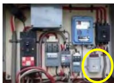
低圧分電盤内の低圧コンデンサー
