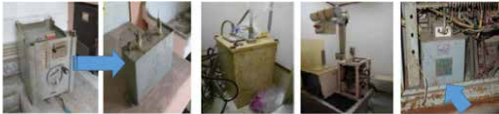
制御盤 (低圧進相コンデンサ)
