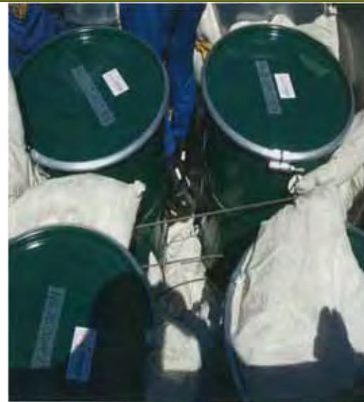
③トレイ内の漏れ対策に吸収材を入れる
