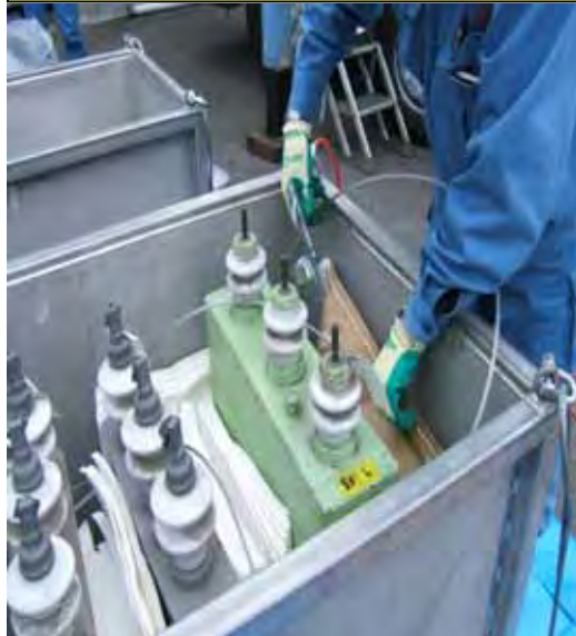
③トレイ内の漏れ対策に吸収材を入れる
