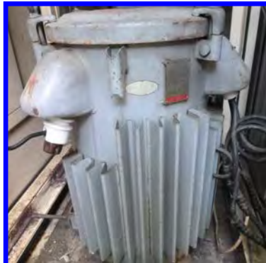
トランス（変圧器）
